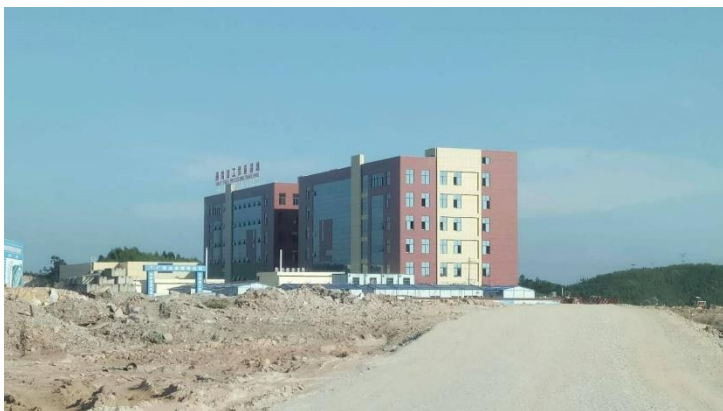
อาคารแปรรูปรังนกกำลังก่อสร้าง
