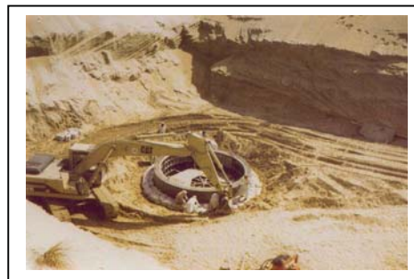
การขุดบ่อเก็บน้ำทะเลใต้ดิน
