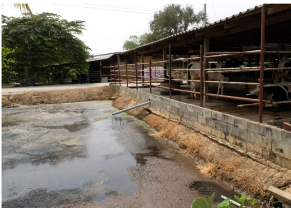
ภาพที่ 4-6 บ่อน้ำทิ้งของฟาร์มโคนม
