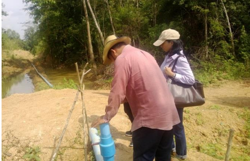
รูปที่ 3 (ก3) ท่อส่งน้ำที่ได้รับการสนับสนุนจากโครงการตอบแทนคนดี (มูลนิธิปิดทองหลังพระฯ) ที่บ้านตัด
